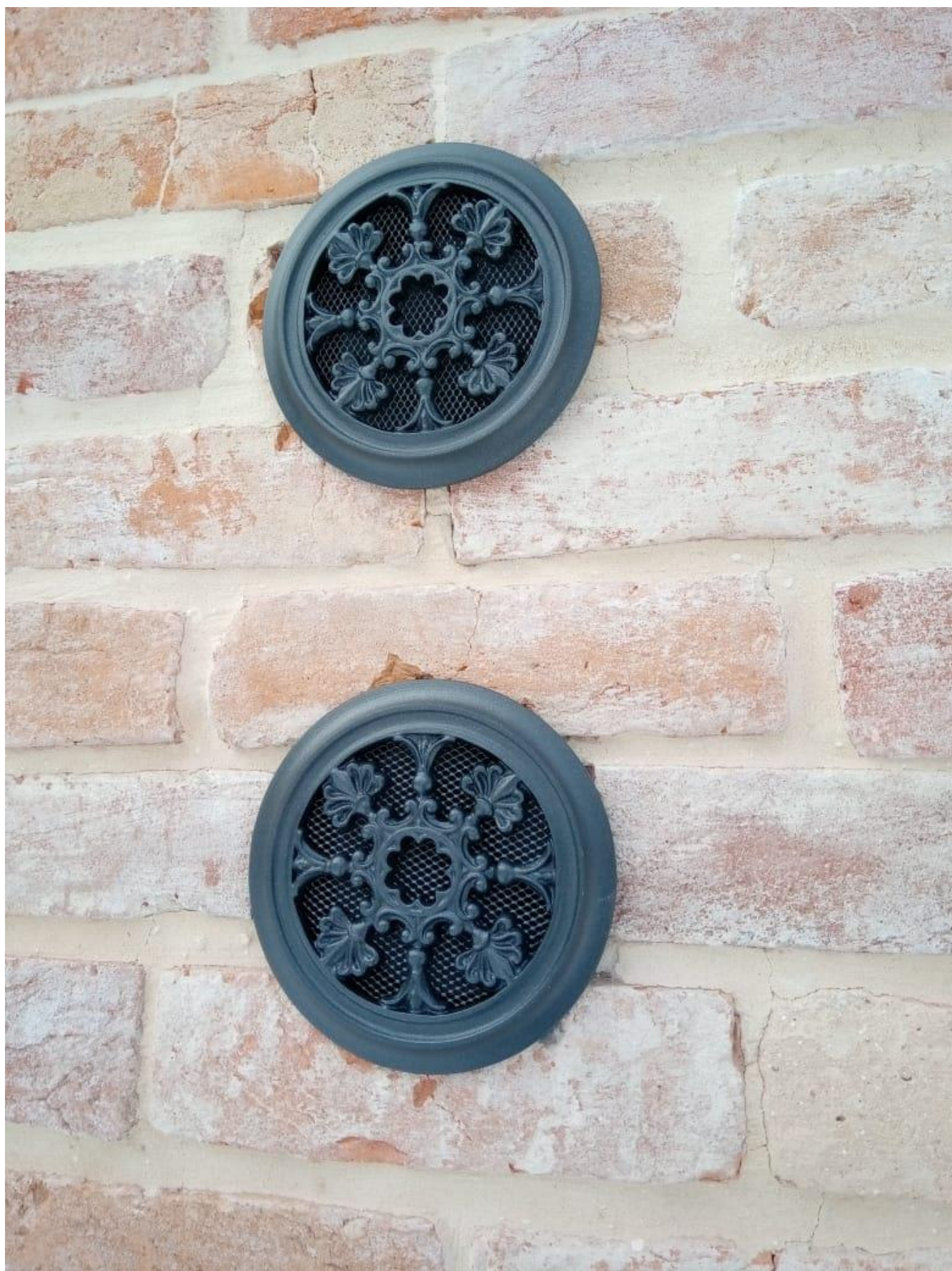
Фото 5. Наружные решетки, установленные в канал.
