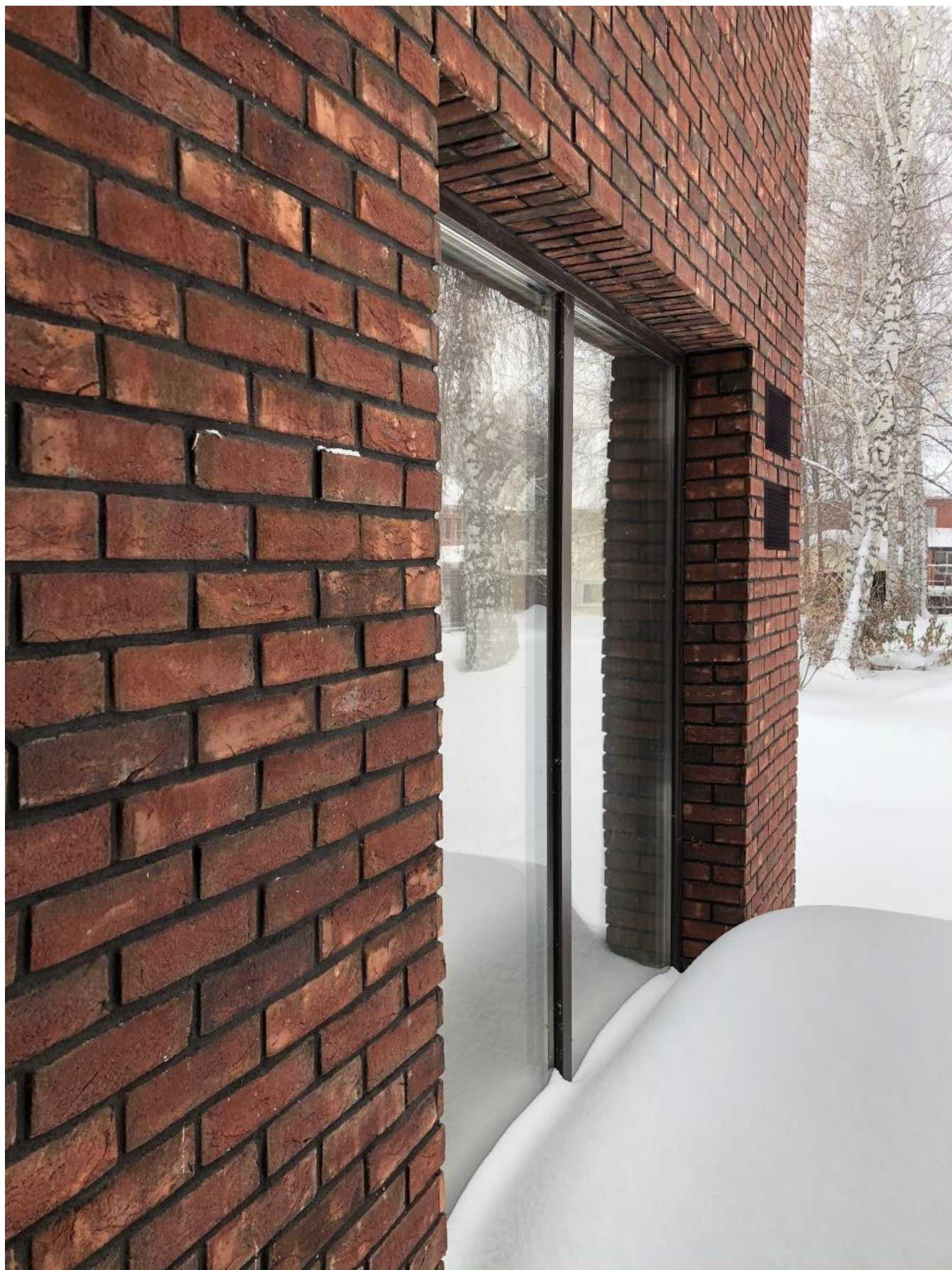
Фото 4. Наружные решетки, установленные в канал.
