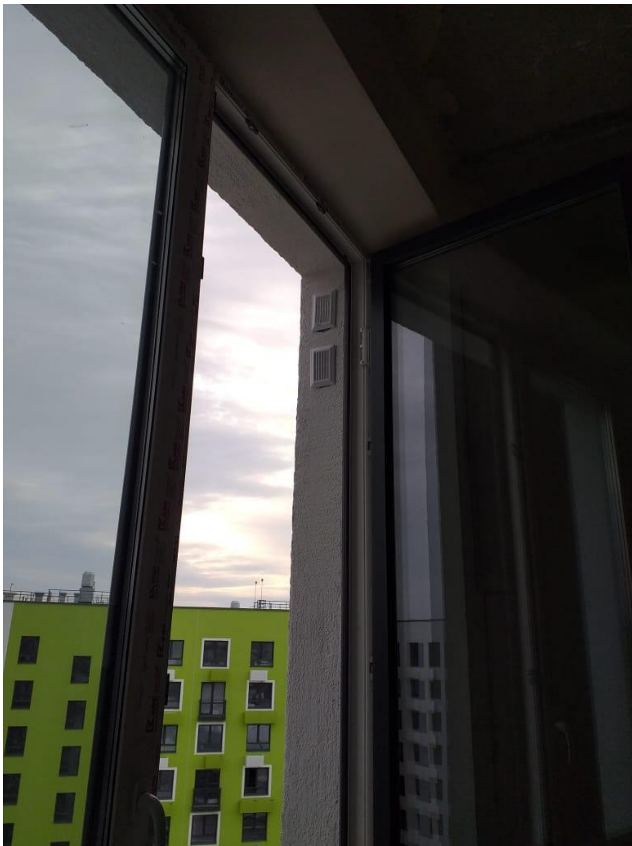
Фото 4. Наружные решетки, установленные в канал, в откосе.
