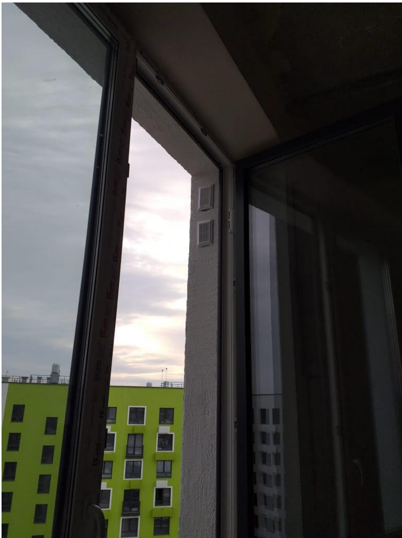
Фото 4. Наружные решетки, установленные в канал, в откосе.
