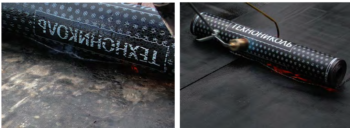
Рис. 7. Валик расплавленного битумно-полимерного вяжущего
